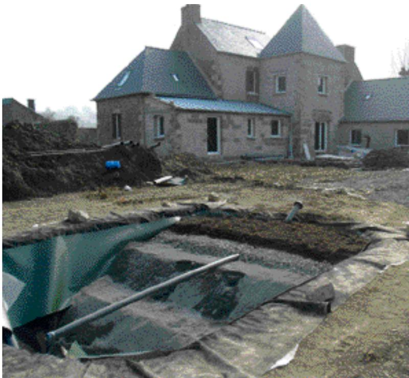
***Le FPR en cours d'installation à Paimpol. Au-dessus du massif filtrant, sur lequel est posé le circuit d'arrivée des eaux usées, on distingue une couche de gravier 2-6 de 40 cm d'épaisseur, moins susceptible de colmatage que la couche superficielle de 40 cm, en sable 0,4. Les roseaux seront plantés régulièrement dans le sable et pousseront en deux ans. L'ensemble est installé dans une géomembrane doublée par un film antipoinçonnant.***
